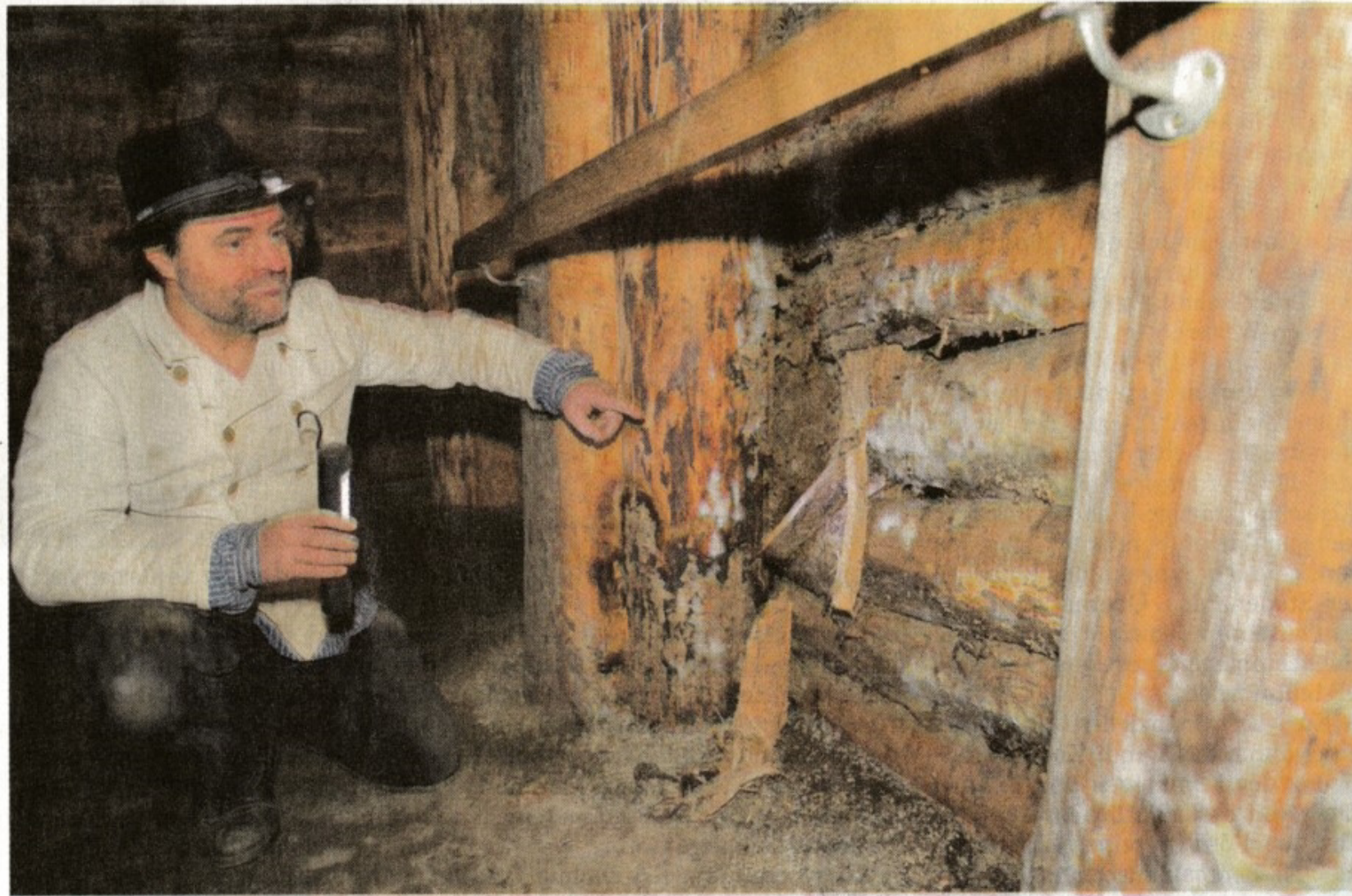
Ulrich Reiff zeigt den weißen Hausschwamm, der die Holzbohlen in der Wetterstrecke befallen hat.
